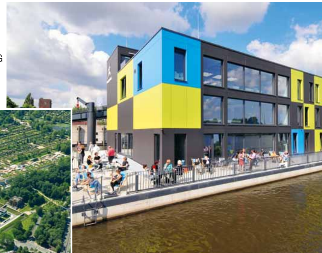
IBA Dock är en simmande byggnad som kan anpassa sig till olika vattennivåer. Foto: Martin Kunze/IBA Hamburg GmbH.
