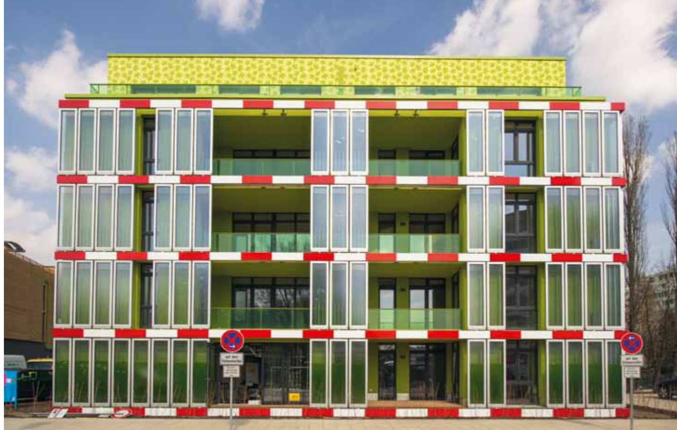
Fasad med inbyggda glaselement, där mikroalger ska kunna odlas och sedan användas till biomassa, el och värme. Foto: Johannes Arlt/IBA Hamburg GmbH.
