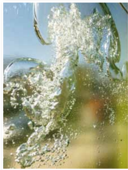
Fasad med inbyggda glaselement, där mikroalger ska kunna odlas och sedan användas till biomassa, el och värme. Foto: Johannes Arlt/IBA Hamburg GmbH.
